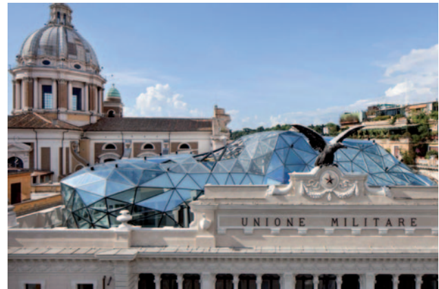
Ex palazzo dell’Unione Militare di Via Tomacelli
